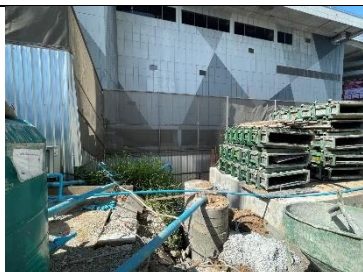
รูปที่ ๗7.33 ถังบำบัดน้ำเสียสำเร็จรูป ในพื้นที่ก่อสร้าง
