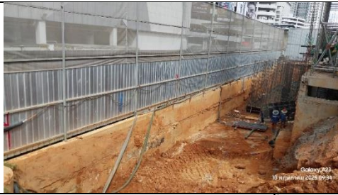
รูปที่ ๗.๑ กำแพงกันดินตลอดแนวอาคารชั้นใต้ดิน
