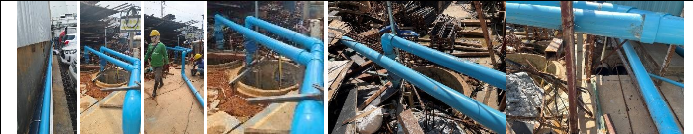
รูปที่ ๗.๒ ท่อระบายน้ำชั่วคราว และบ่อดักตะกอน
