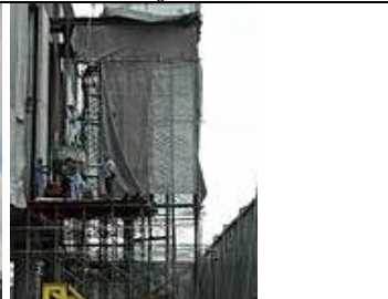
รูปที่ ๗7.55 นักร้านเหล็กซึ่งด้วยผ้าใบ เพื่อป้องกันเศษวัสดุร่วงหล่น
