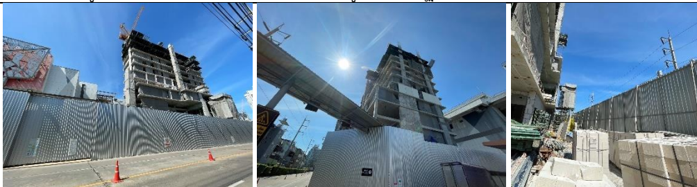
รูปที่ ๗7.10 รั้วทึบกันบริเวณพื้นที่ก่อสร้าง
