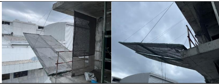
รูปที่ ผ7.57 Chain link ยื่นจากอาคารขณะทำโครงสร้างอาคาร
